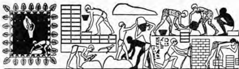
Fig. 18: Trabalhadores estrangeiros efetuando obras de alvenaria, no Egito.
